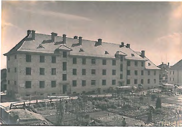
Metzstraße 37-39 im Rohbau , 1926 (Die Familie Högg wohnte im ersten Stock ganz links)
