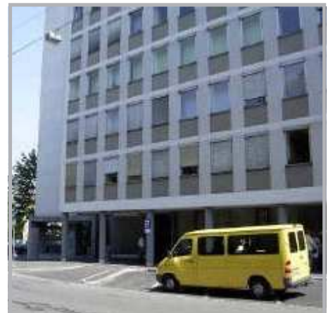
Heutiges Verwaltungsgebäude der Stadt Augsburg
